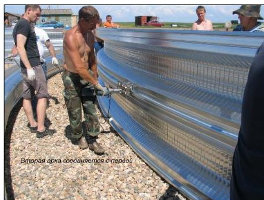
Рис. 2. Арки соединяются между собой в секции по 3 ед. с помощью ручной электрической забортовочной машины.
