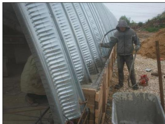
Рис. 5. После устройства опалубки производится бетонирование.
