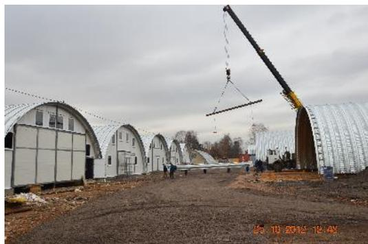
Рис. 8. Вариант утепленного ангара. Возможность плавного изменения радиуса строительных арок позволяет строить утепленные ангара путем возведения сооружения одного над другим с зазором в 0,15-0,20 м. Объем
