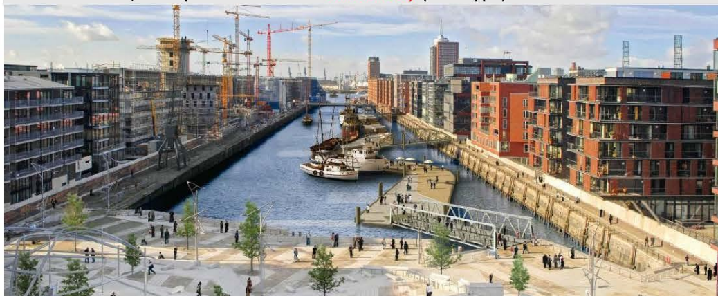
Ревитализация порта - комплекс Hafen City (Гамбург)
