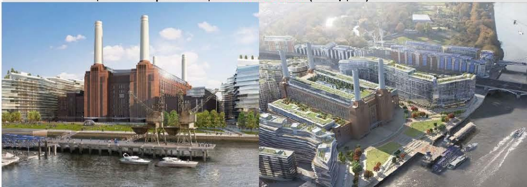
Ревитализация электростанции BATTERSEA (Лондон)
