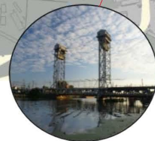
Двухъярусный мост, 1914 – 1926 гг.
