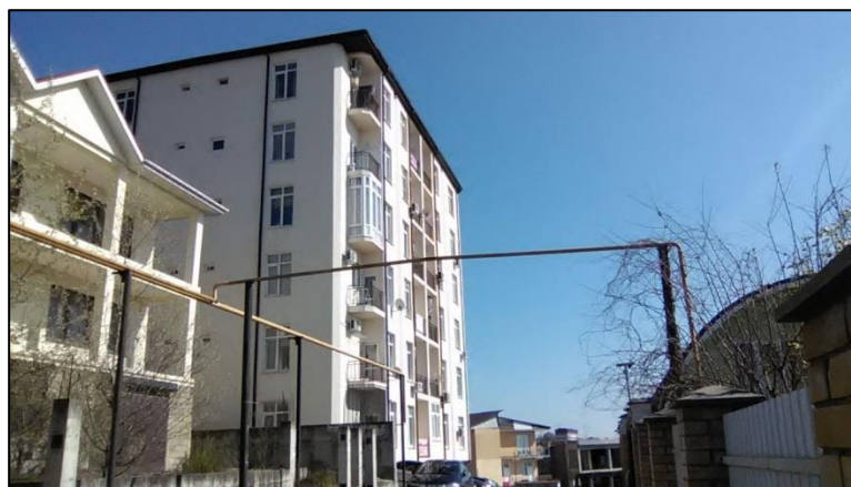
Фото 2. Строительство частного многоквартирного дома в Адлерском районе г. Сочи
