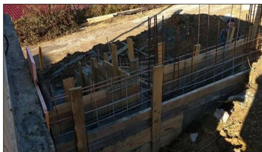
Фото 2. Монтаж опалубки для подпорной стены
