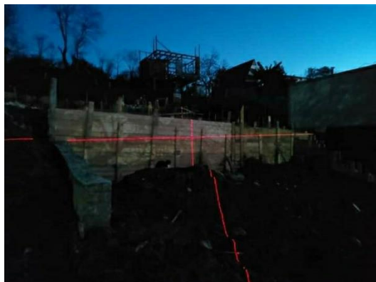
Фото 4. Проверка монолитной конструкции лазерным уровнем. Отклонение от вертикали
