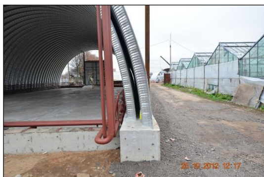
Рис. 8. Вариант утепленного ангара. Возможность плавного изменения радиуса строительных арок позволяет строить утепленные ангара путем возведения сооружения одного над другим с зазором в 0,15-0,20 м. Объем между наружной и внутренней ограждающими поверхностями сооружения при необходимости может быть заполнен любым теплоизолирующим материалом (пенопласт, перлит, эковата, минеральная вата и т. п.).
