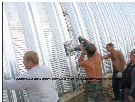
Рис. 3. С помощью автокрана арочные секции устанавливаются в вертикальной плоскости и соединяются между собой также с помощью забортовочной машины.
