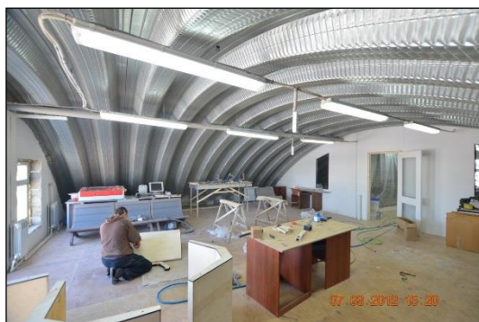
Рис. 7. Вариант утепленного ангара, разделенного по горизонтали на два этажа, для размещения мебельного производства.
