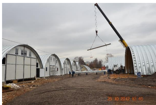
Рис. 8. Вариант утепленного ангара. Возможность плавного изменения радиуса строительных арок позволяет строить утепленные ангара путем возведения сооружения одного над другим с зазором в 0,15-0,20 м. Объем между наружной и внутренней ограждающими поверхностями сооружения при необходимости может быть заполнен любым теплоизолирующим материалом (пенопласт, перлит, эковата, минеральная вата и т. п.).
