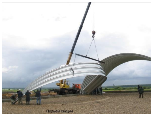
Рис. 3. С помощью автокрана арочные секции устанавливаются в вертикальной плоскости и соединяются между собой также с помощью забортовочной машины.
