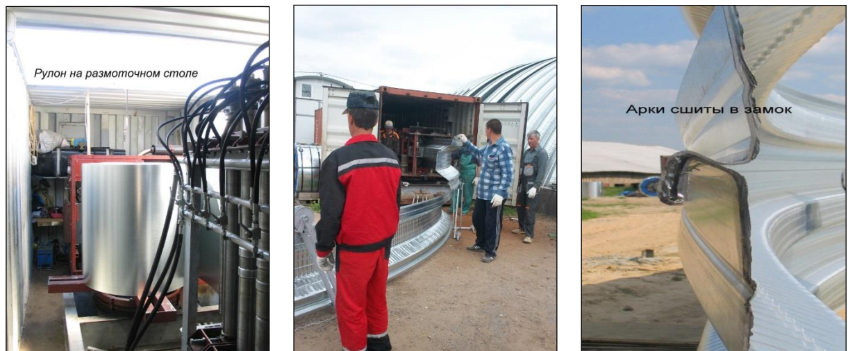
Рис. 1. Изготовление (формовка) строительных элементов (арок).
