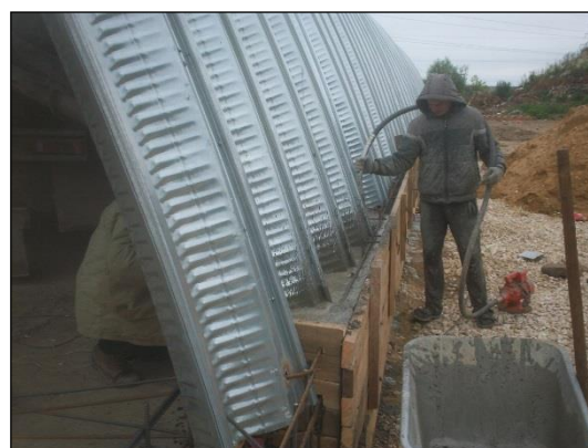
Рис. 4. Нижние концы арок, образующих сооружение, устанавливаются на опорный уголок и крепятся к нему (опорный уголок является частью арматурного каркаса ростверка).
