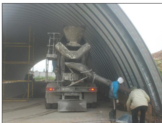
Рис. 5. После устройства опалубки производится бетонирование.
